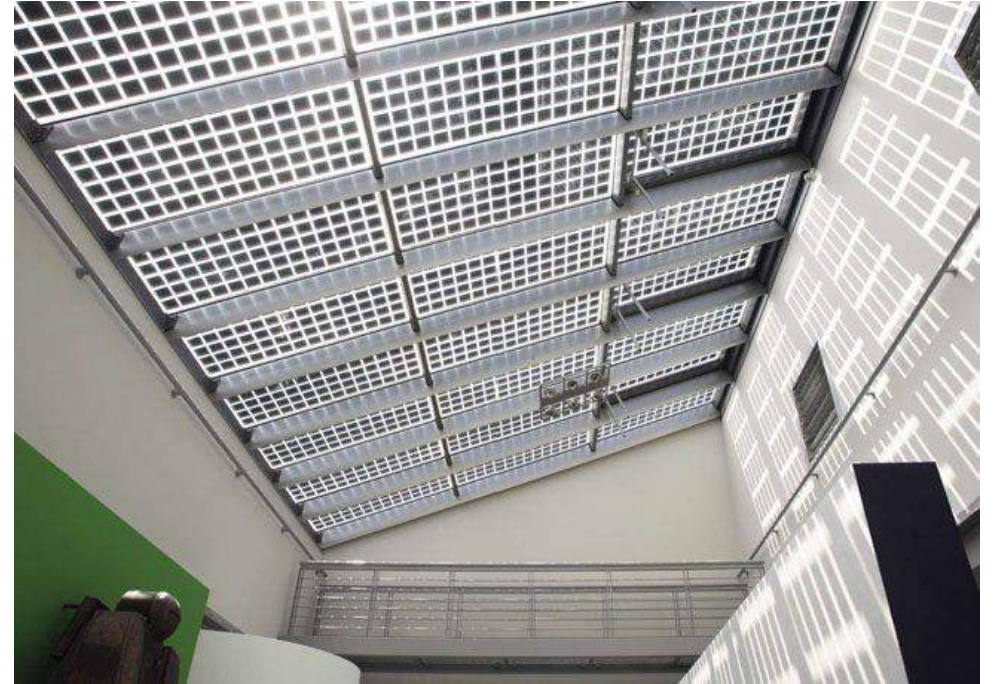
Cubierta translúcida y lucernarios
